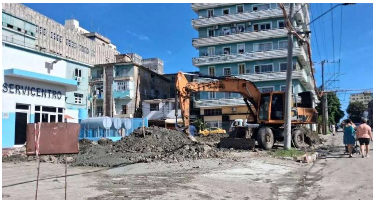
En el servicentro cercano al Ministerio de las Fuerzas Armadas, una excavadora abre un boquete descomunal. / 14ymedio
