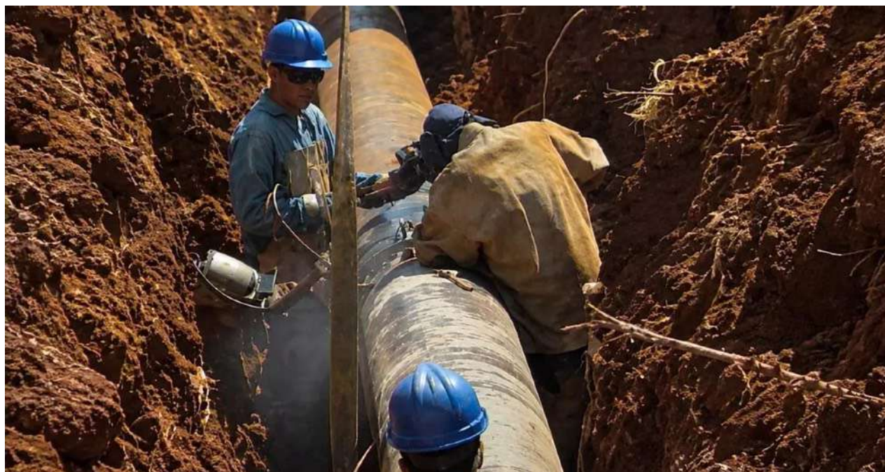
La reparación del Oleoducto Magistral Varadero-Matanzas se realizó en condiciones de "alta peligrosidad". / Cuba Hoy
