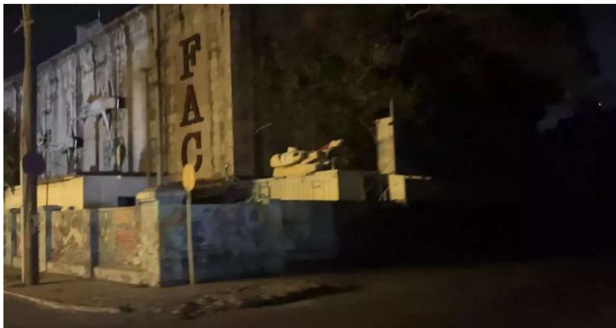
Exteriores de la Fábrica de Arte Cubano, completamente apagados. / 14ymedio
