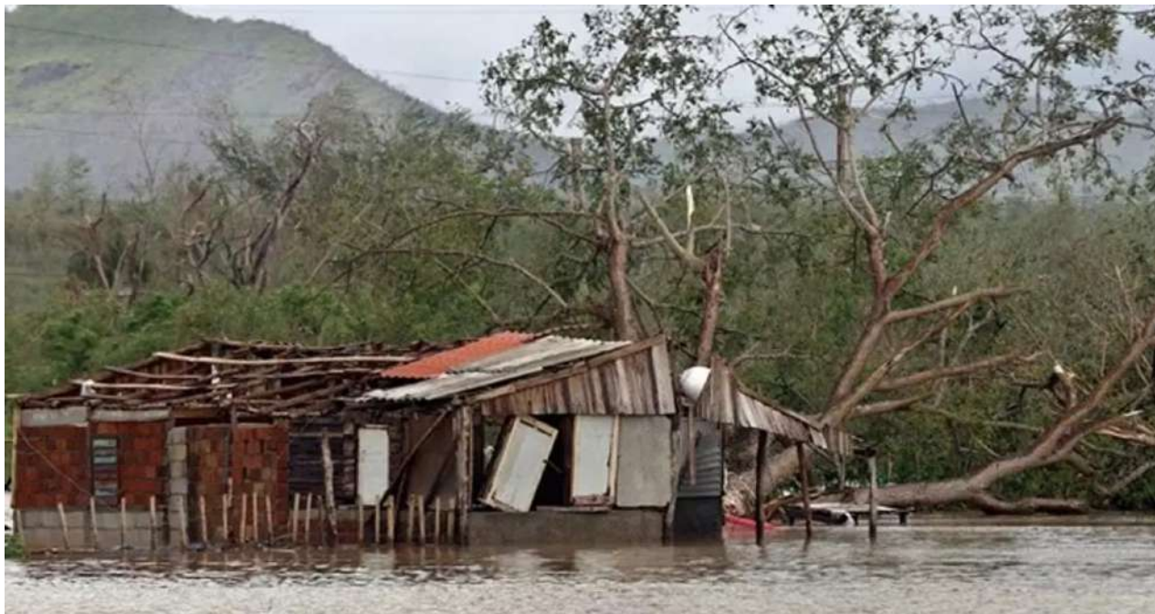
Vivienda inundada por la crecida de un río, este miércoles, en el poblado de Guama, en Santiago de Cuba. / EFE/Ernesto Mastrascusa
